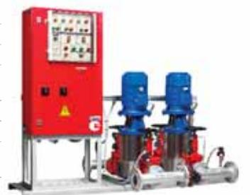
**Область применения:** сплинкерные и дренажные системы пожаротушения, системы с гидрантами, специсполнения для совмещенных хозяйственных и пожарных систем.
