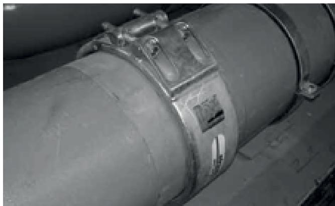
Система охлаждения двигателя, рабочее давление 6 бар, температура до 60 °C
