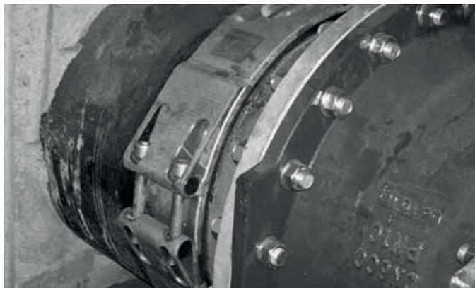
Компенсация разности диаметров при установке запорно-регулирующей арматуры
