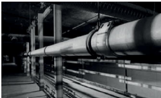
STRAUB-METAL-GRIP – это соединение высочайшего качества для туннелестроения: испытания под ударной нагрузкой до 200 г
